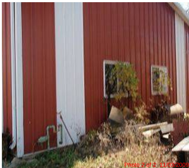
11/3/2009 - 30X30 MTL BLDG (BACK)
