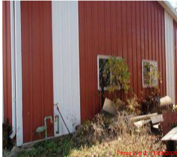
11/3/2009 - 30X30 MTL BLDG (BACK)
