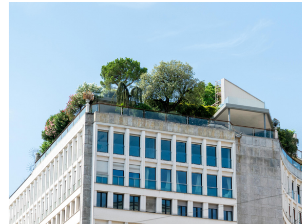
F70. Green Roof (Florinel Condruz, 2022)
