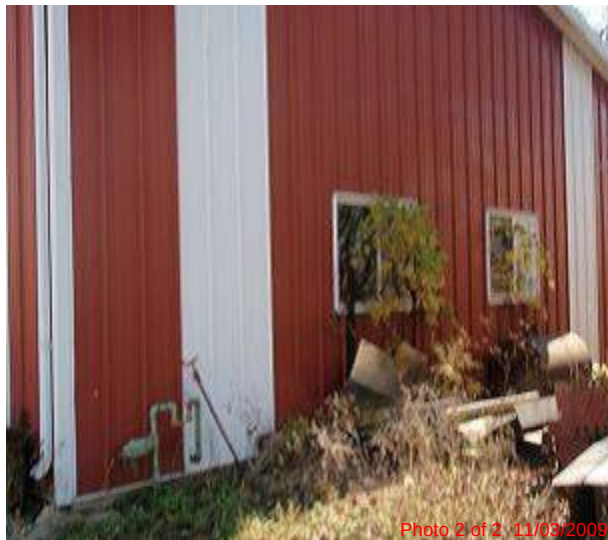
11/3/2009 - 30X30 MTL BLDG (BACK)
