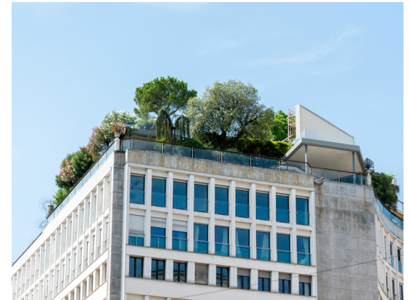
F70. Green Roof (Florinel Condruz, 2022)
